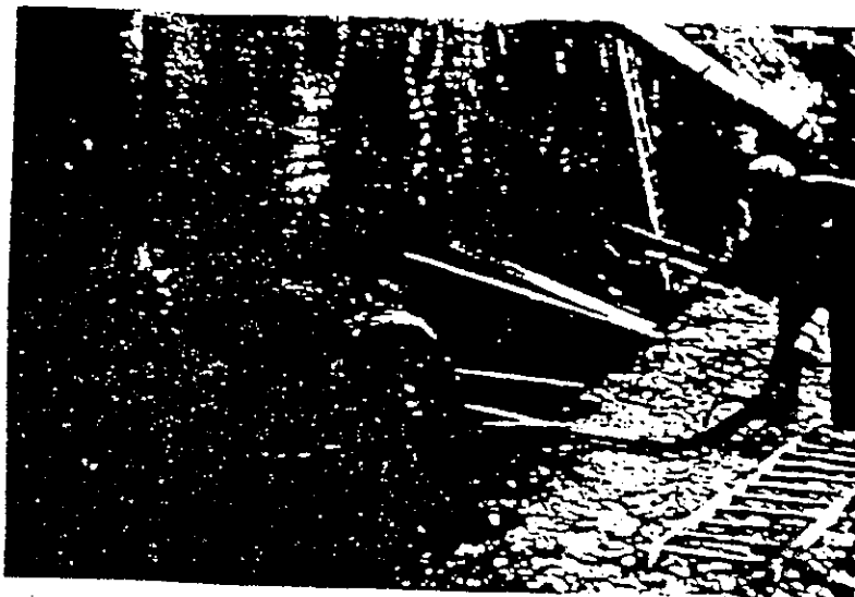
Clouage et béton projeté
